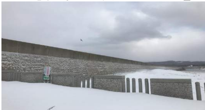
大規模防潮堤(奥尻町)
